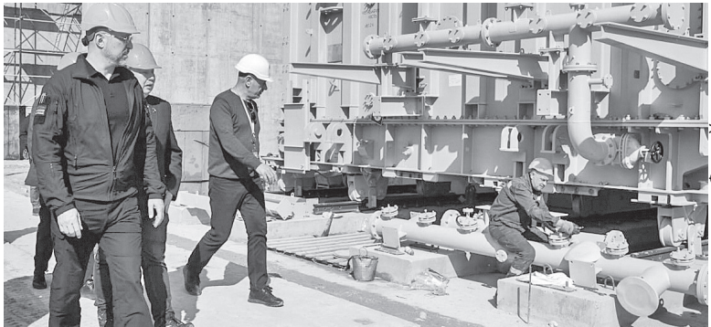
Денис Шмигаль оглянув перебіг будівництва другого рівня захисту на енергетичних підстанціях
